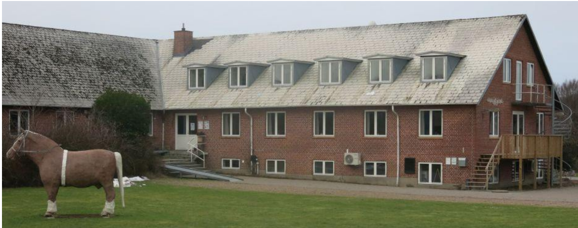
Facade mod Skagen Landevej efter vinduer er skiftet på kviste, i stue- og kælderetagen.
